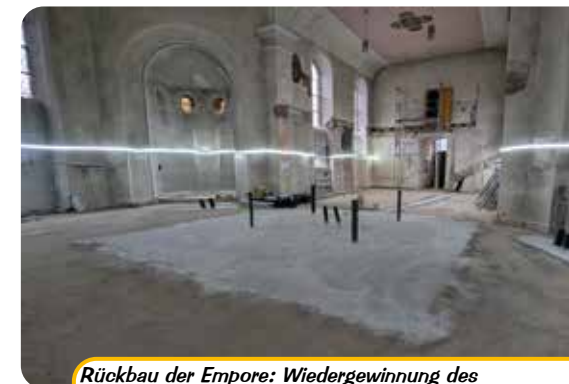
Rückbau der Empore: Wiedergewinnung des historischen Kirchenraums für die Werktagsskapelle
