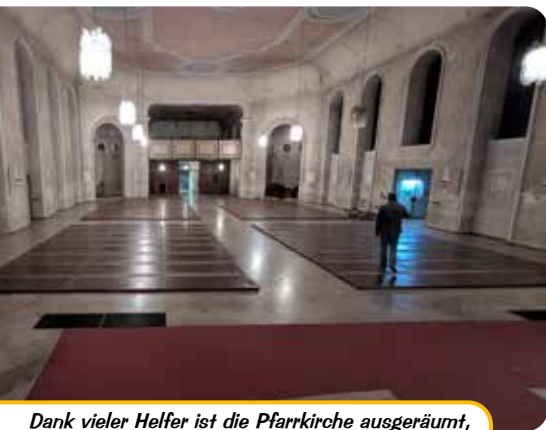
Dank vieler Helfer ist die Pfarrkirche ausgeräumt, die Sanierungsarbeiten können beginnen
